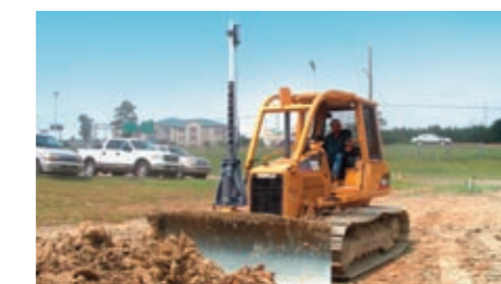
Preparación de proyectos de obras
