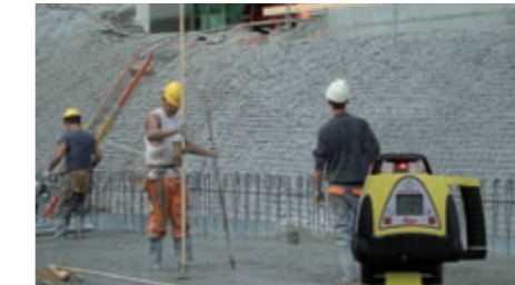
Coladas de hormigón
